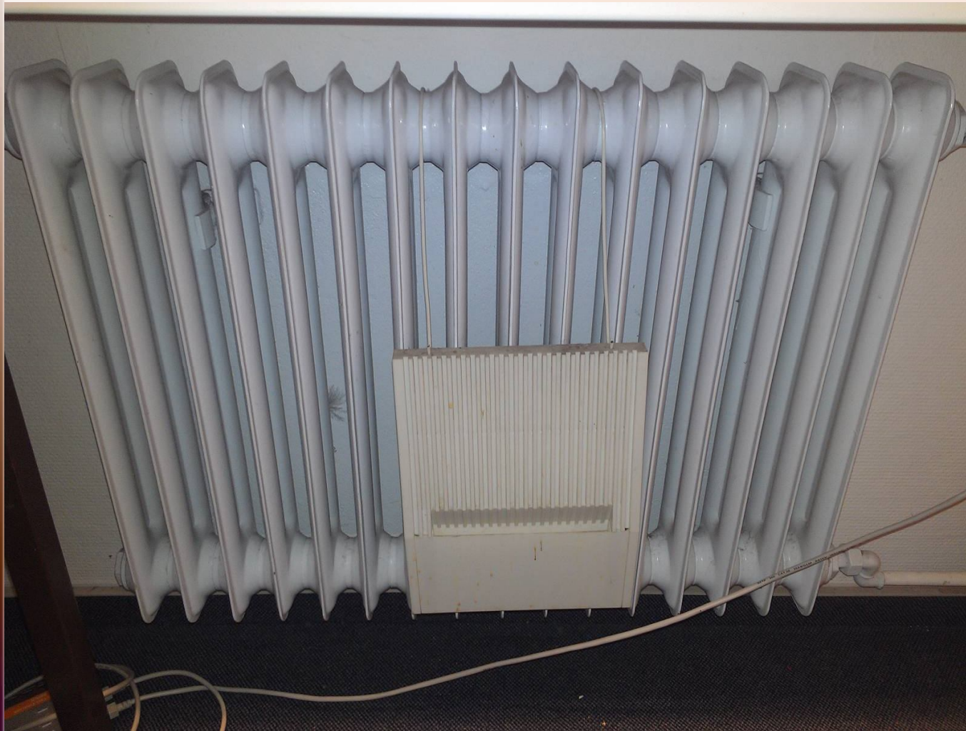
Ein Rippenheizkörper 1965 mit Luftbefeuchter
