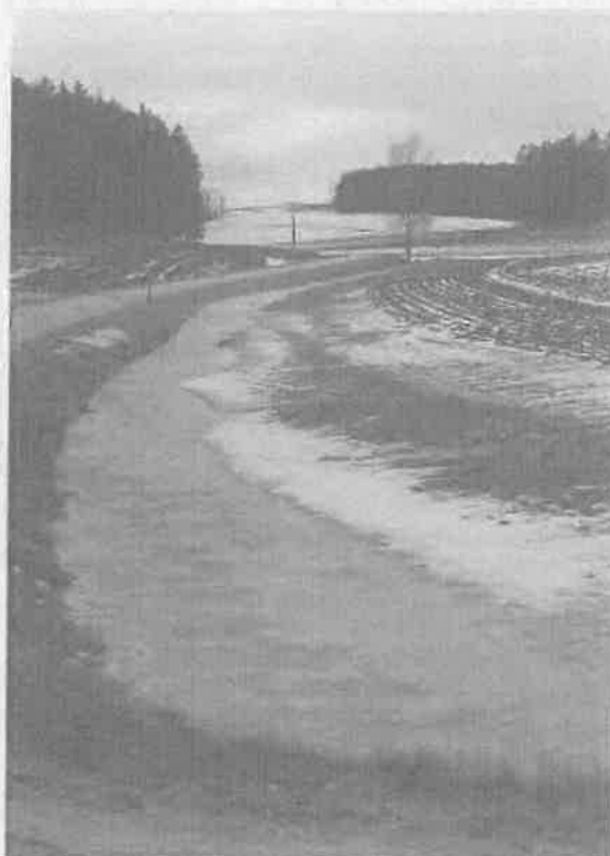
Bild 1.5: Wegeseitengräben steuern den Wasser- und Stoffhaushalt der Landschaft entscheidend mit
