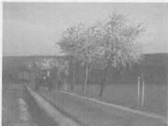
Bild 2.10: An den vorhandenen Baumbestand angepasste Linienführung eines Hauptwirtschaftsweges
