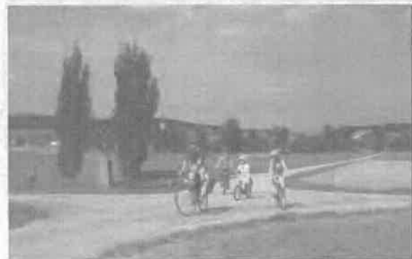
Bild 2.23: Kreuzung Ländlicher Wege (plangleicher Knotenpunkt)
