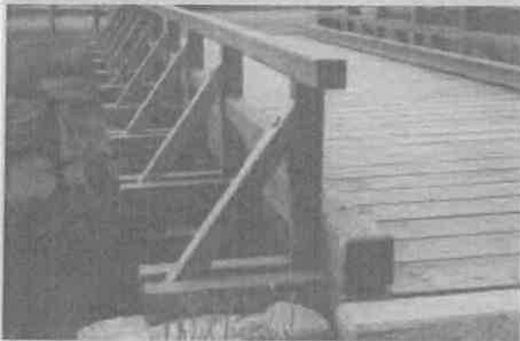
Bild 3.7: Holzbrücke auf Stahlträger
