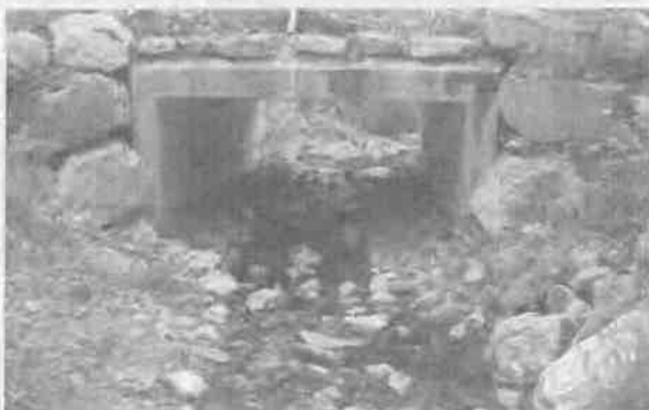
Bild 2.24: Angegliederte Gewässersohle im Brückenbereich
