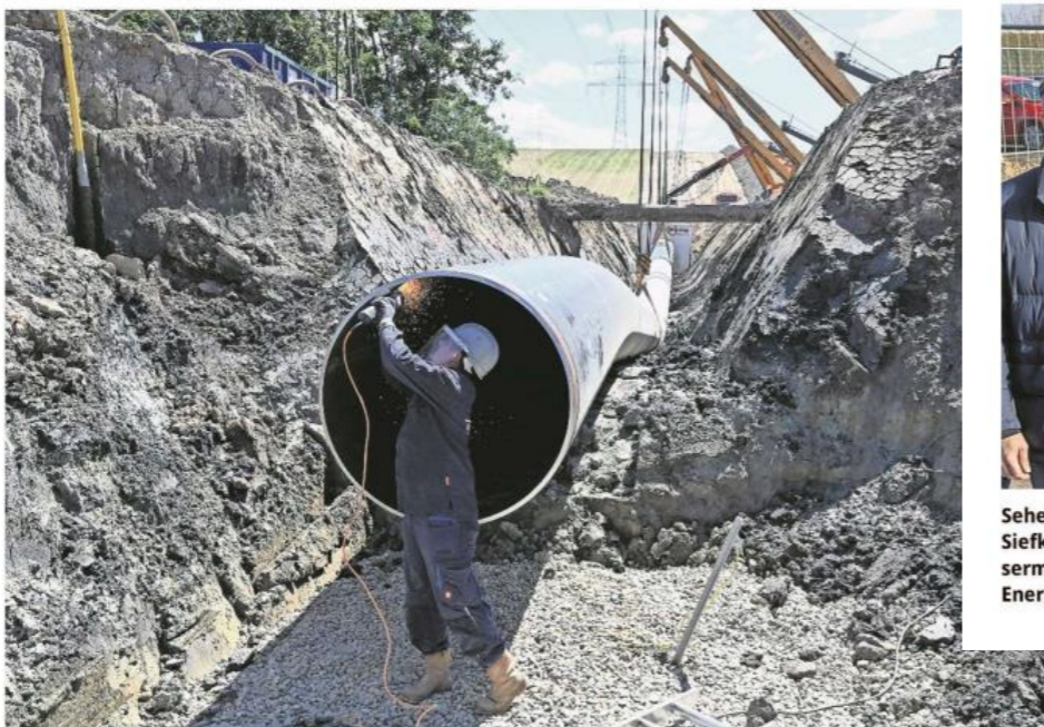
Symbolbild von einer Baustelle in Baden-Württemberg: Der Weg für eine Pipeline, die vor allem große industrielle Anbieter in der Wesermarsch mit Wasserstoff versorgen soll, ist jetzt frei. Das sagen die vor Ort verantwortlichen Akteure zu der guten Nachricht. Foto: Weißbrod/dpa
